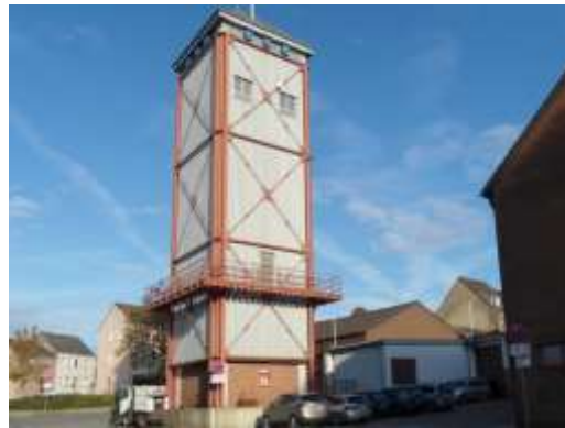
Abbildung 31: In der Mitte der Schlauchturm der Feuerwache und rechts davon die Arbeitshallen
