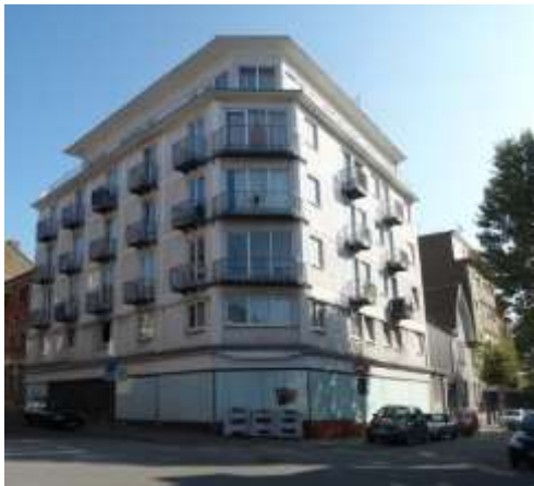
Abbildung 8: Gebäude mit mehr als vier Vollgeschossen in der Gatterstraße 16
