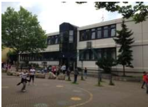
Abbildung 32: Blick auf die Grundschule Bergstraße über den Schulhof
