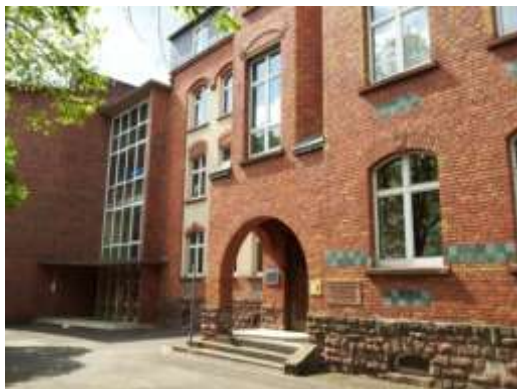
Abbildung 38: Eingangsbereich der Mühlgewannschule
