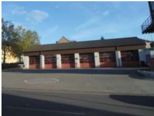
Abbildung 30: Blick auf die bestehende Fahrzeughalle der Feuerwache in der Danziger Straße
