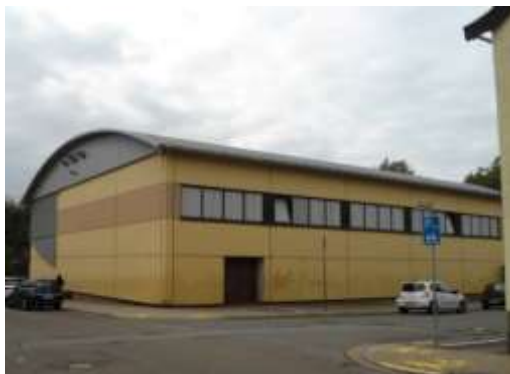
Abbildung 33: Turnhalle der Grundschule Bergstraße aus Richtung Hochstraße
